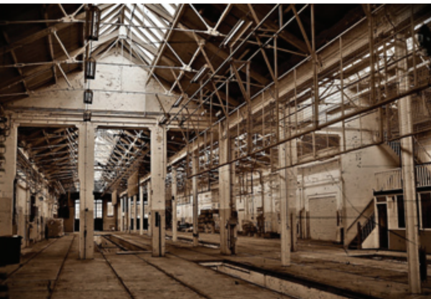
Figuur 27; Tramremise Amsterdam, na enkele jaren leeg te hebben gestaan. 34 Bron: (Rijksdienst voor cultureel erfgoed, 2014c)
