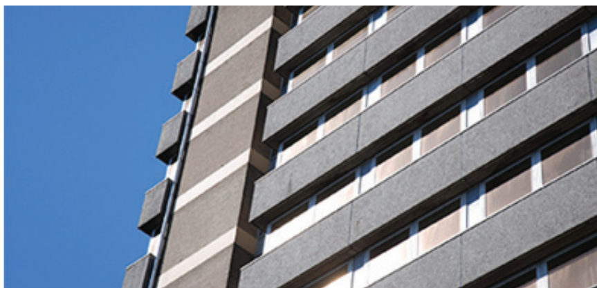
Figuur 18; Zusterflat, Delft voor de transformatie Bron: (SHS Delft, 2014)
