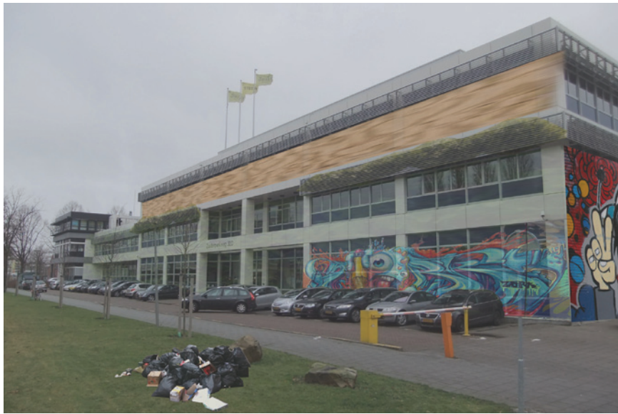
Figuur 11; Voormalig Eneco kantoor verpauperd Bron foto: eigen illustratie
